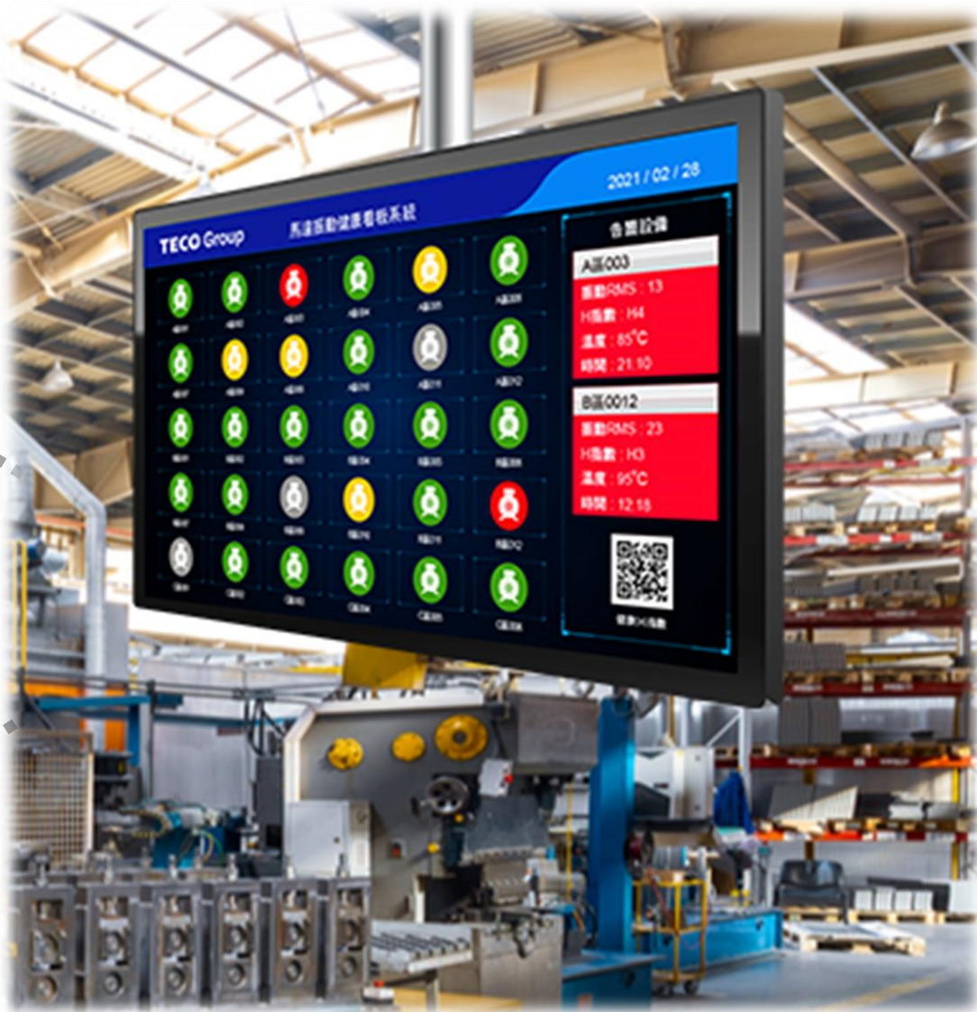
自動巡檢看板 現場檢視
